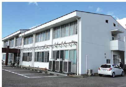
三田建設技能研修センター本館
