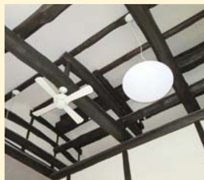
梁などを残し、古民家ならではの良さを活かしたリフォーム
