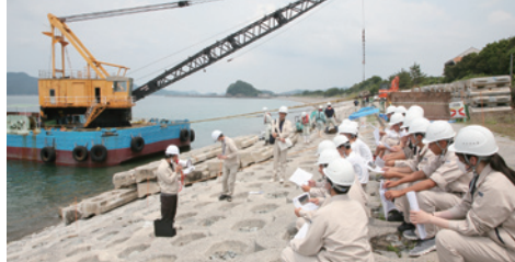
只の浜海岸 海岸災害復旧工事
