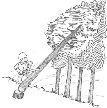
図5 かかっている木の元玉切り
